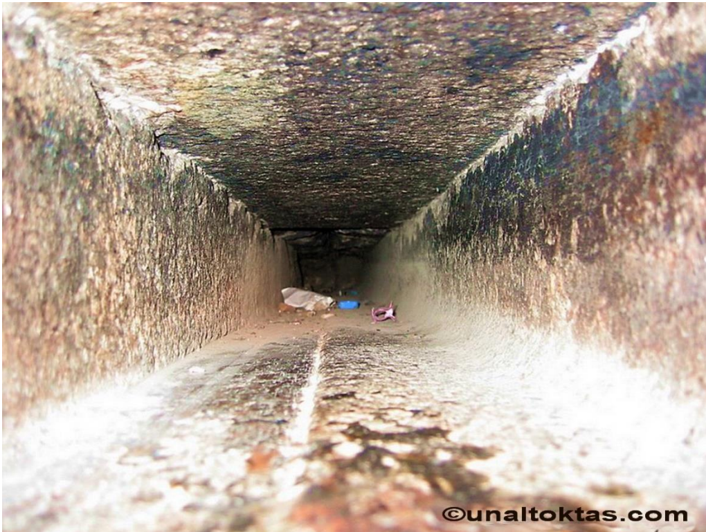
Kral Odasının kuzey duvarındaki havalandırma kanalı
