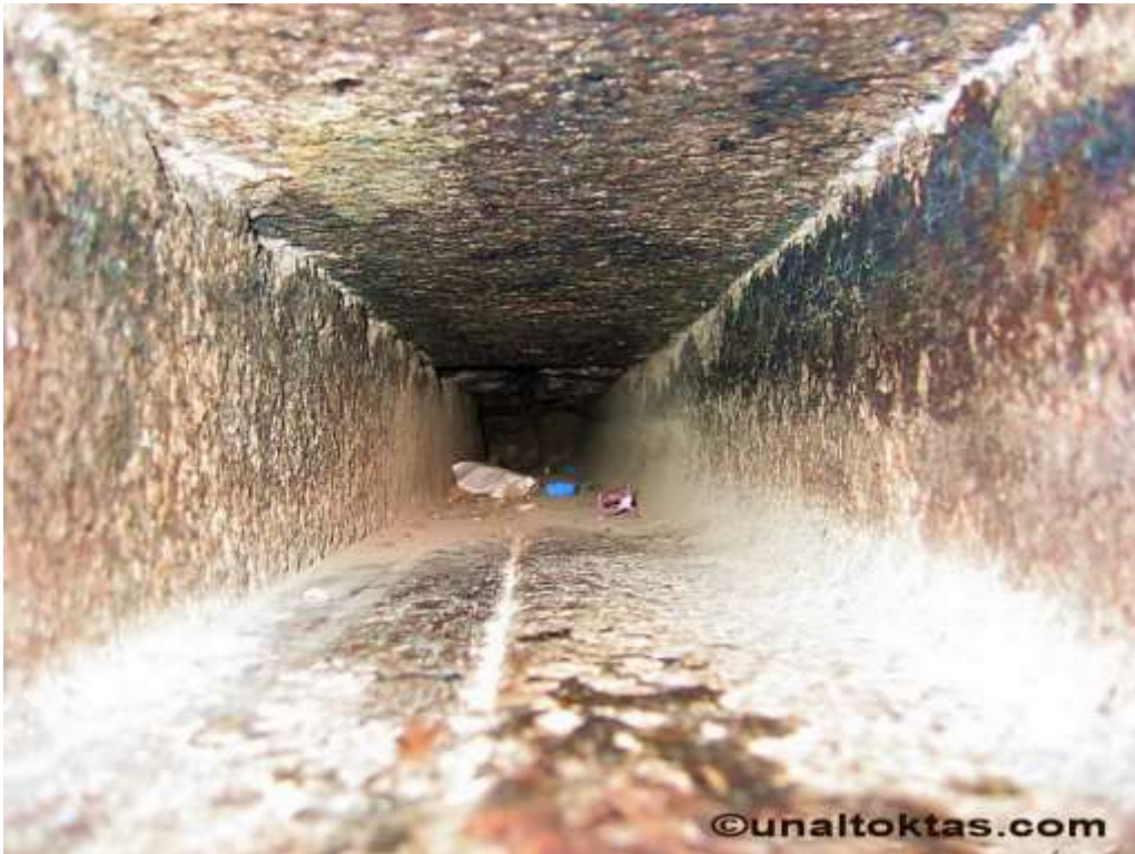
Kral Odasının kuzey duvarındaki havalandırma kanalı
