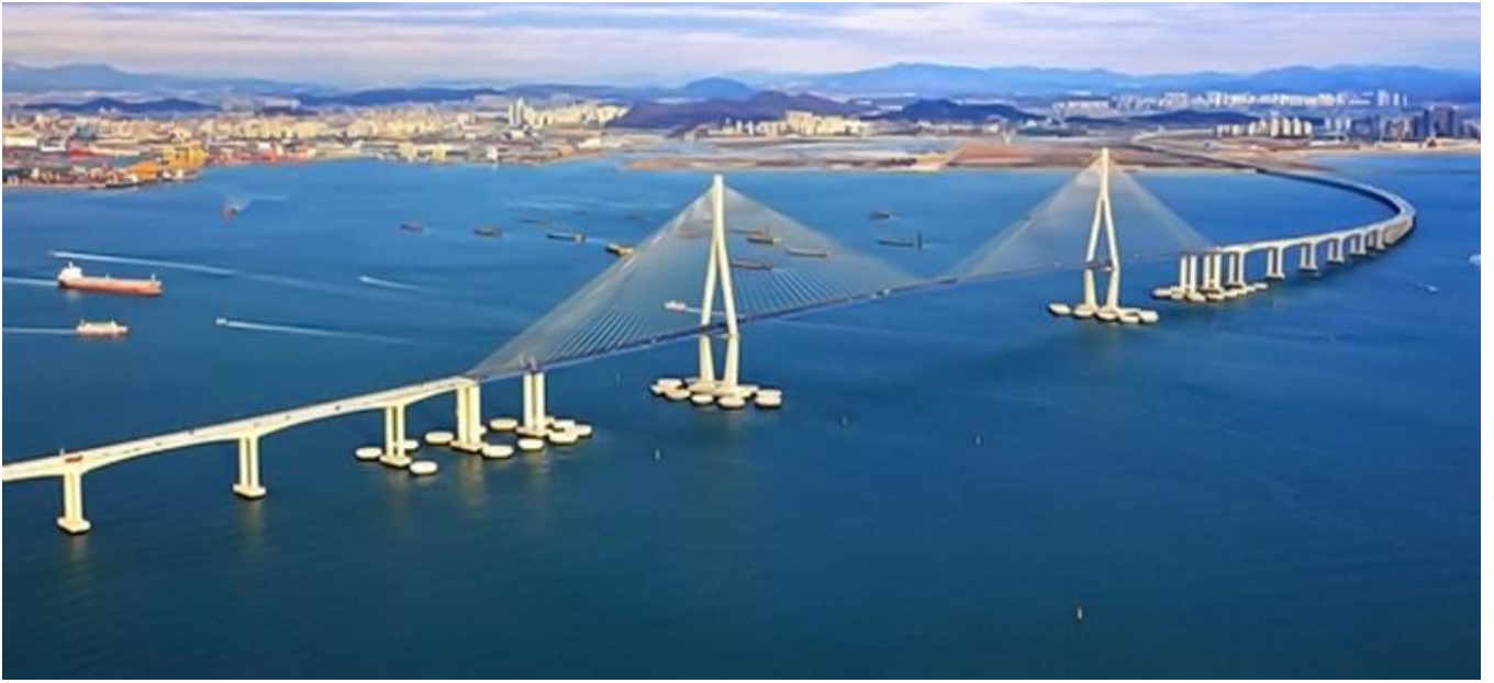
Havaalanı ile şehir arasındaki asma köprü
